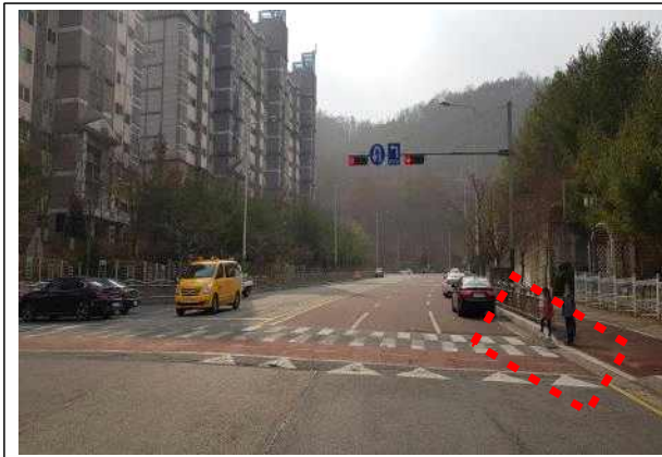
④ 금암초교- 점자블럭 및 진입억제말뚝 미설치
